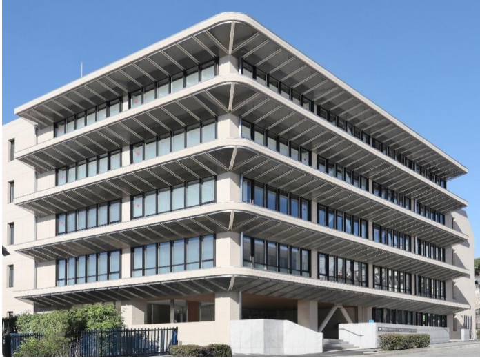
兵庫県福祉人材研修センター外観
