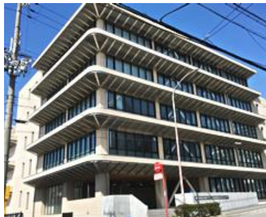
兵庫県福祉人材研修センター 外観
