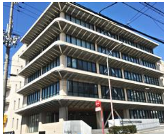
兵庫県福祉人材研修センター 外観
